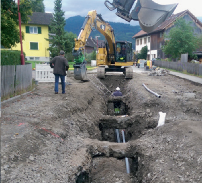
Wasserleitungsbau in der Alemannenstraße
